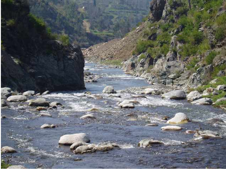
ダム軸直下流部
