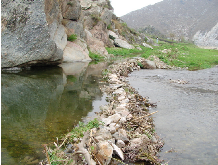
ダム軸直下流部に設けられた堰。下流にある Kundal 村、約 150 エーカーを灌漑
