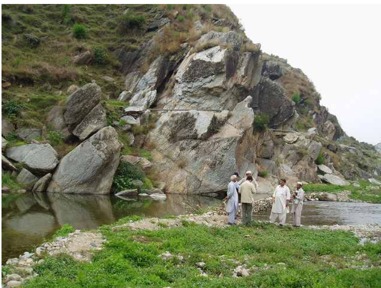
ダム軸直下流部
