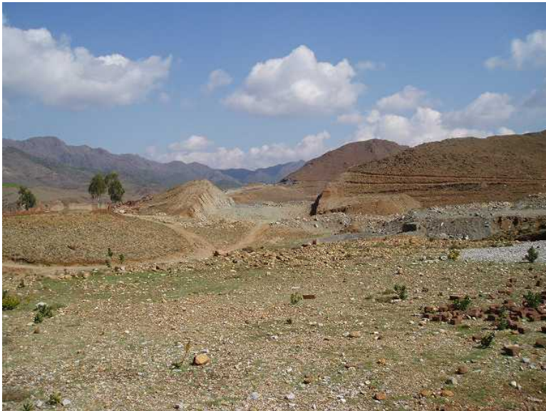
建設が途中で中断された洪水吐き (下流部より撮影)
