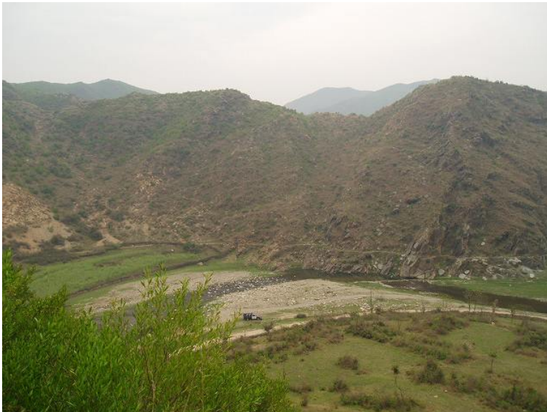
ダム軸 (ダムサイト右岸より撮影)
