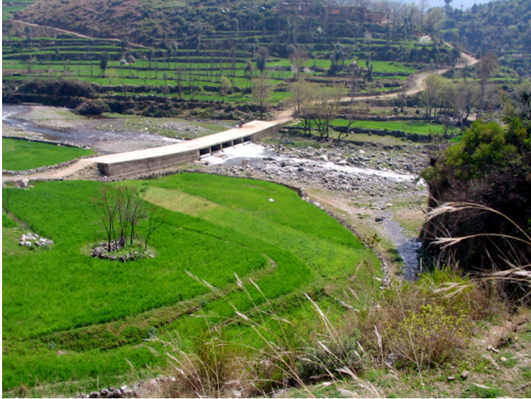
ダム軸直上流部（この地域は、ダム建設によりほとんどが水没すると思われる）
