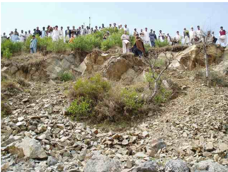
ダム軸右岸部
