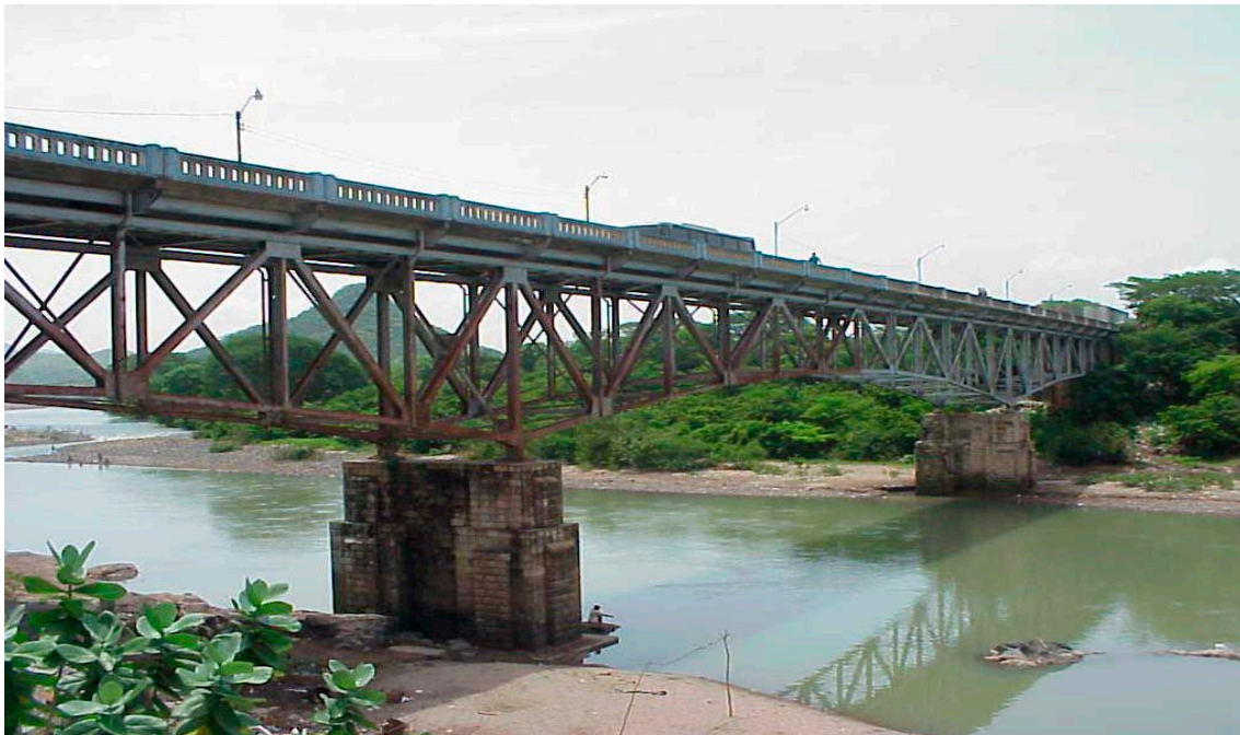
図 2-5 既存ゴアスコラン橋写真
