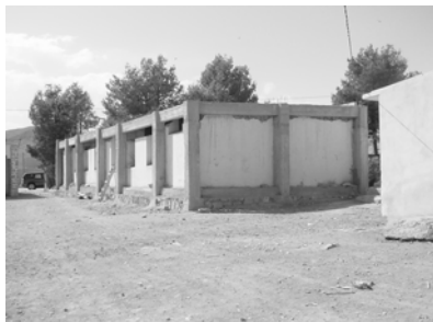
Prov. Boulmane Enjil Ikhataran Renforcement de la structure des salles de cours en préfabriqué
