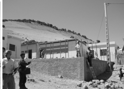
Prov. Khénifra Moulay Yacob Construction du mur de soutènement de clôture
