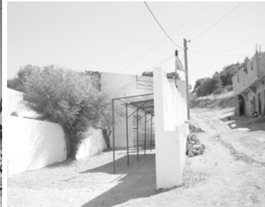
Prov. Khénifra Sidi Yahya Ousaad Construction de clôtures et d'un chemin d'entrée couvert
