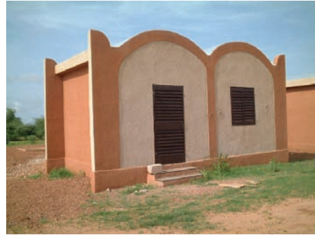
LUX 学校倉庫棟
