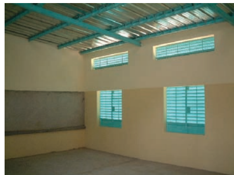
KfW 学校の内部状況
