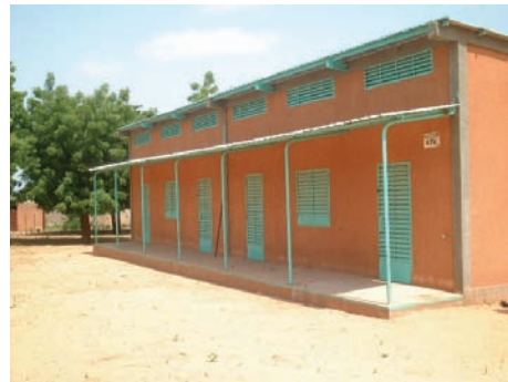
KfW(ドイツ)学校 2 期/ガラス部分鉄骨
