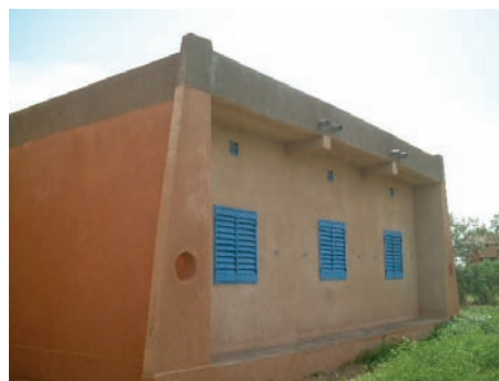
屋根スラブ+屋根折板の二重屋根
