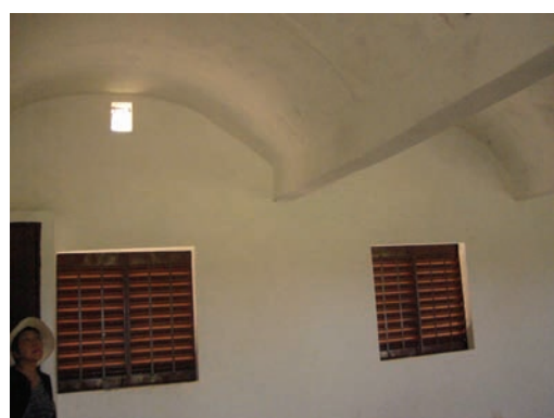
プランニジェールによる建設施設 (ルクセンブルク協会の円形スラブ構造を取り入れたもの)
