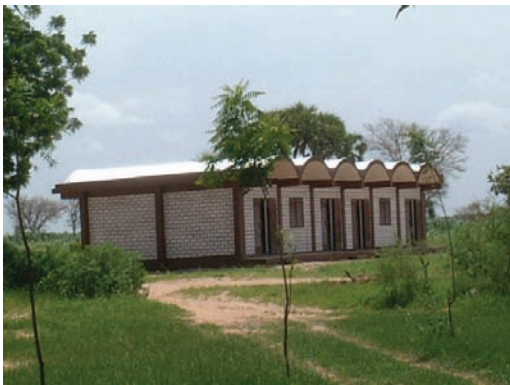
プランニジェールによる建設施設 (ルクセンブルク協会の円形スラブ構造を取り入れたもの)
