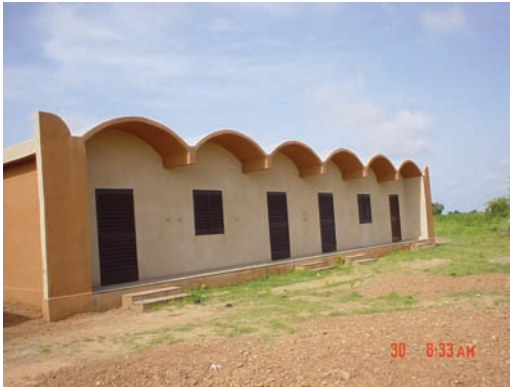
ルクセンブルク協会による建設施設 (天井なし・円形スラブ構造) 右: 裏側 雨水貯水パイプつき
