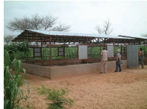
WBによる施設 軽量鉄骨 (セミ・ディフィニティブ) 教室
