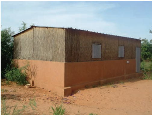
WBによる施設 軽量鉄骨 (セミ・ディフィニティブ) 教室
