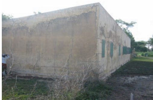
2. Fotoro 学校（老朽化劣悪状態、壁・床クラック大きい）
