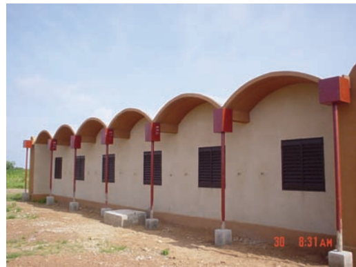
ルクセンブルク協会による建設施設 (天井なし・円形スラブ構造) 右: 裏側 雨水貯水パイプつき
