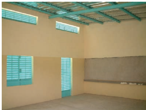
KfWによる建設施設内部
