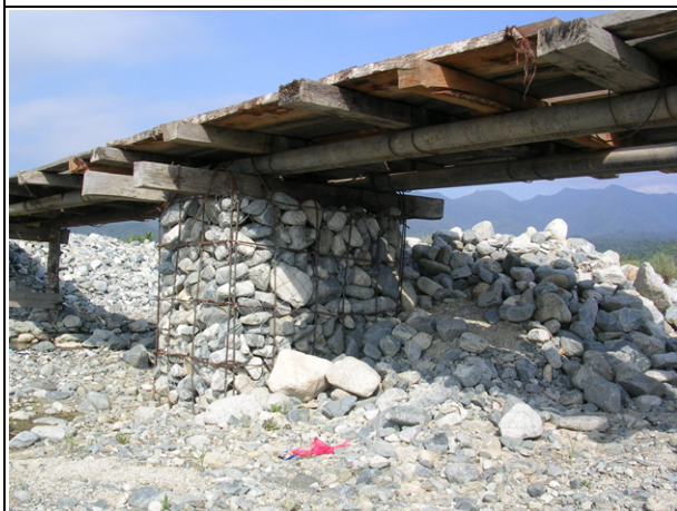
Bazal 橋の橋脚 (蛇籠で建てられている)
