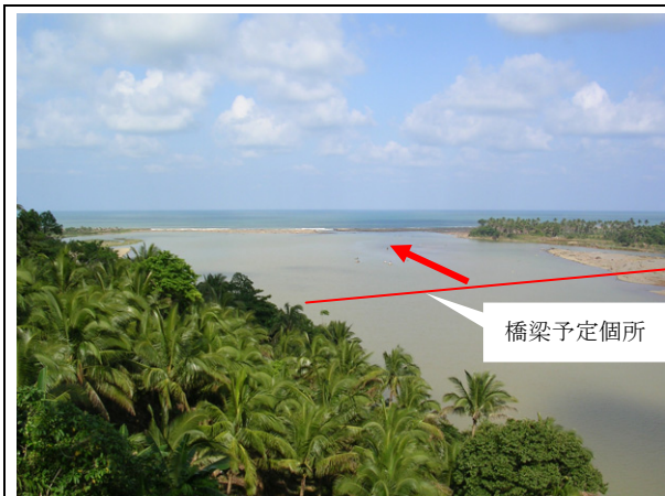
Umiray 橋の全景（正面に海が見られる）
