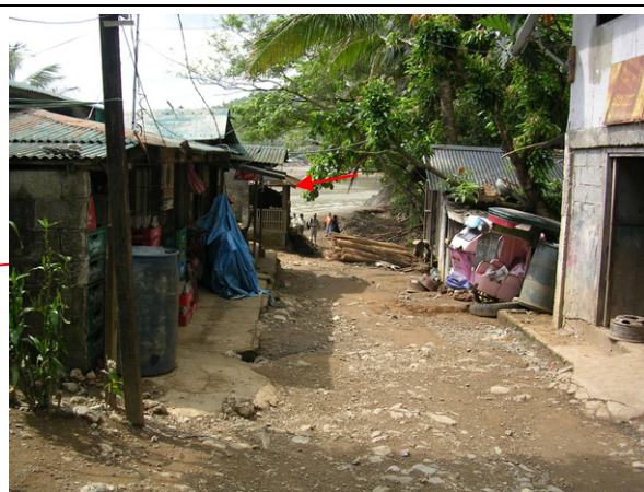
Umiray 橋の取付け道路 （Aurora 州側より望む）
