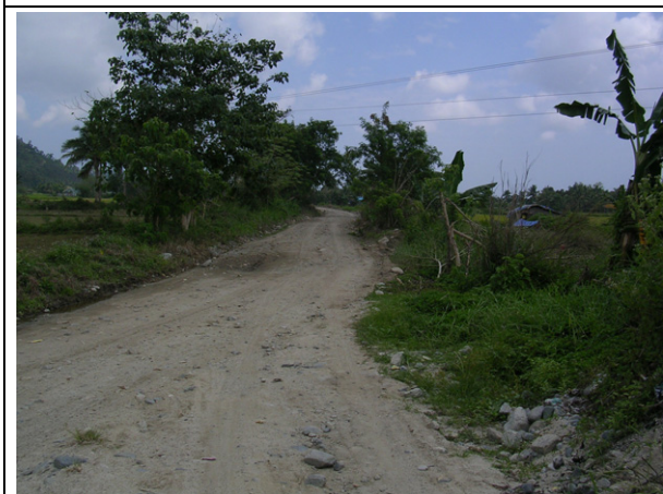
Bazal 橋の取付け道路 (Maria Aurora 側を望む)
