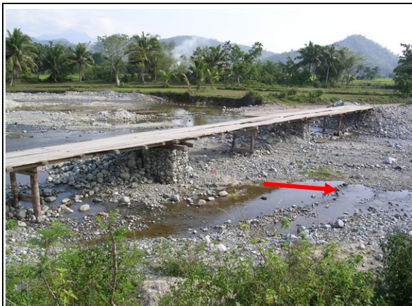
Bazal 橋全景 (橋長 37.0m 幅員 2.5m の木橋) (3月8日撮影)
