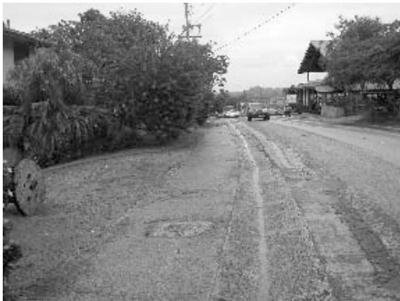
要請車道端はV側溝の中央部
