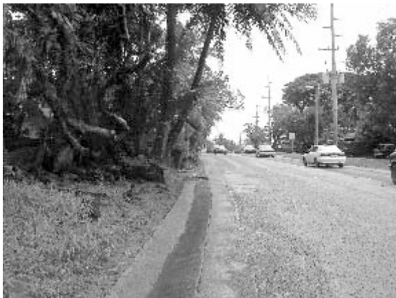
要請車道端はV側溝の中央部
