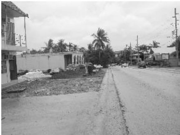
要請車道端はV側溝の中央部
