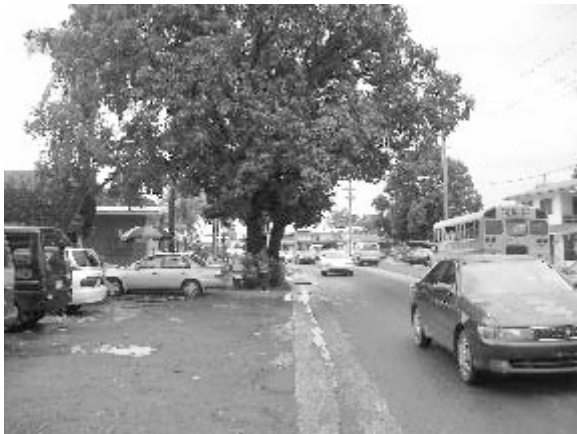
要請車道端はV側溝の中央部分
