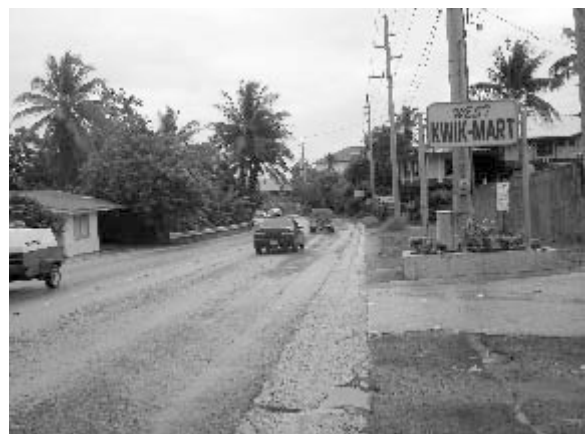
要請車道端はV側溝の中央部
