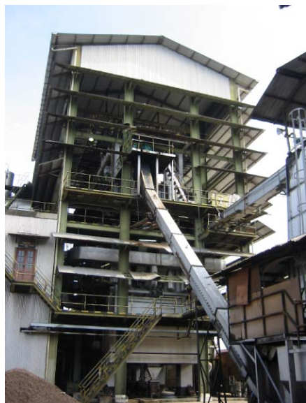
付図 2. 3. 1 ボイラー遠景
