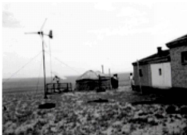
付図2. 4. 3 300W風力発電機の設置
