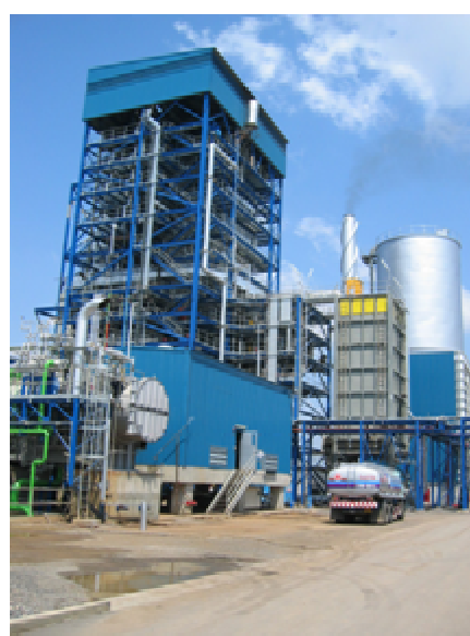
付図2. 3. 7 A T B 籾殻発電所
