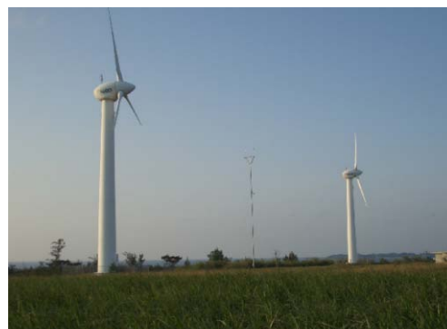
付図 2. 4. 10 離島用風力発電システム (沖縄県伊是名村)
