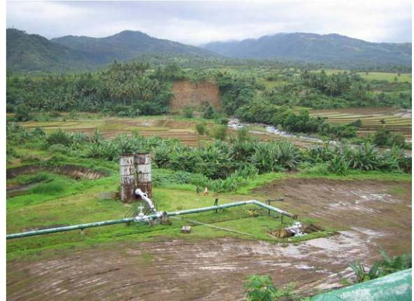
付図 2. 2. 4 マニトローランド地熱発電プラント生産井・セパレータ・滞留槽・配管
