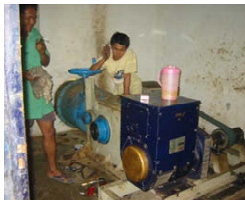
付図 2. 1. 4 ベアリングの取替え作業の状況
