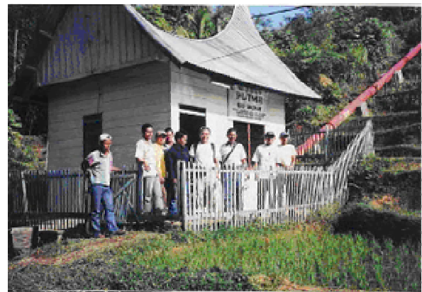
付図2. 1. 1 発電所全景
