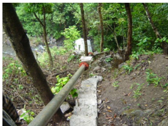
アボボロ発電所
