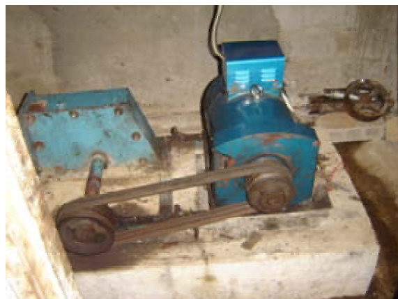
フィリピンの事例：バディアンガン発電所：フィリピン製の水車と中国製の発電機
