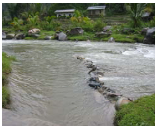
取水ダム（じゃ籠の上に石を並べて取水している）
