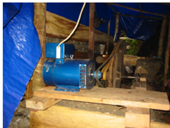
参考：インドネシアの個人用小水力発電（ソロ県）：現地で製作した木製水車と中国製の発電機 工事費(機材含む)はRp.5,000,000(6万円)程度という
