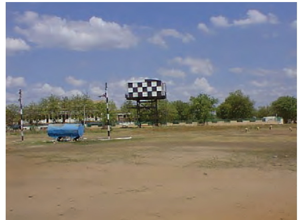
GOSS政府庁舎側の高架水槽
