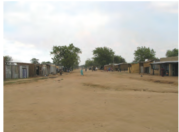
一般的な道路（未舗装でヒビが走る）
