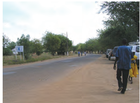
一部舗装道路（舗装面の損傷が目立つ）
