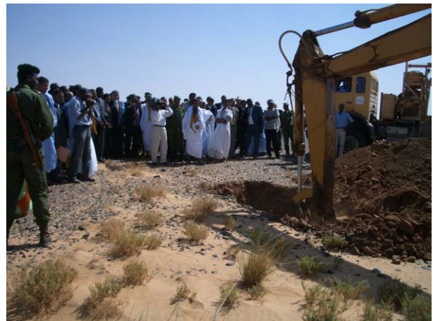
重機による鋤入れ
