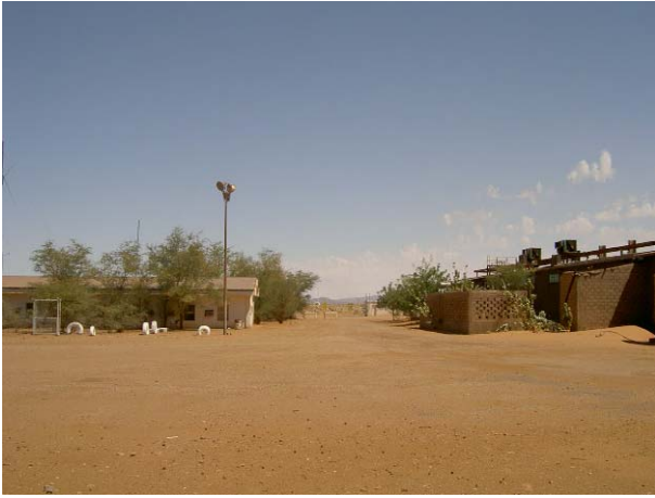
鉱山現場管理事務所
