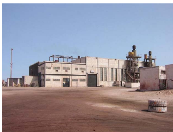
4. チッラーの外観。2つの円形の設備で鉱車を固定、回転し鉱石が落ちる。落下した鉱石は地下のベルコンで貯鉱場(写真撮影不可)に送られる。貯鉱場はから、再び破碎場に送られ、一旦貯鉱し、船積みされる。粉鉱の粉塵が鉱石が落下すると発生する。
