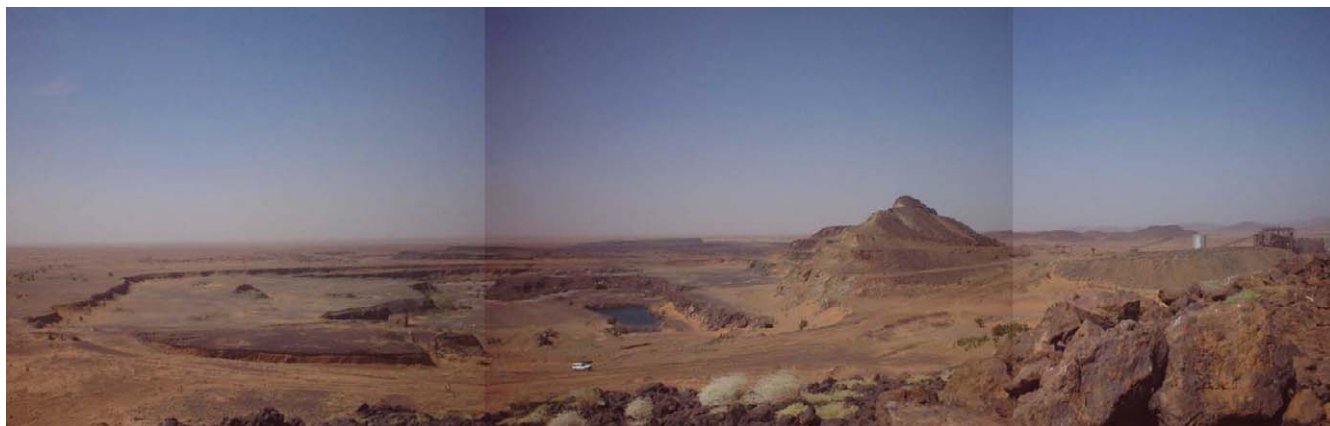
1. アクジュト鉱山 (Guelb Moghrein 鉱床) 露天掘り。南北(写真の左右)400m、東西 500m 1978 年まで採掘、現在休山中。
