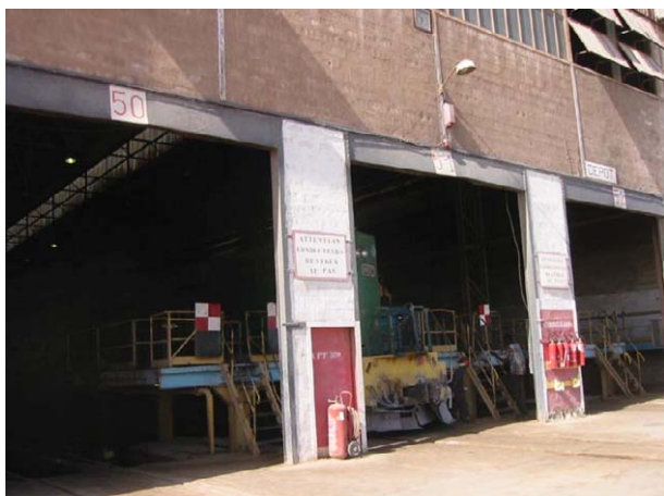
1. 機関車日常点検ショップの入り口。TQC の看板が見える。鉱石輸送は3機関車連結で100台の鉱車(総重量20,000t)を牽引する。NDBにはこれ以外に定期点検ショップと鉱車修理ショップがある。
