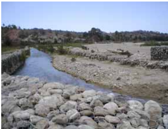
労働集約工事で完成した堤防
