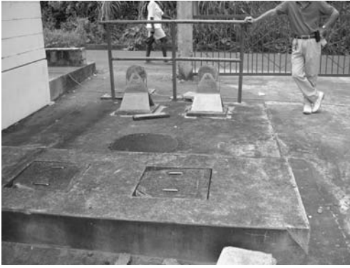
浄化槽上の攪拌用プーリー (シャトーブレール、撮影日：2005年8月9日)
