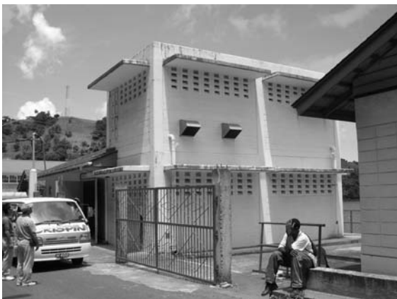
シャトーブレール水産センター入口 (撮影日：2005年8月9日)
