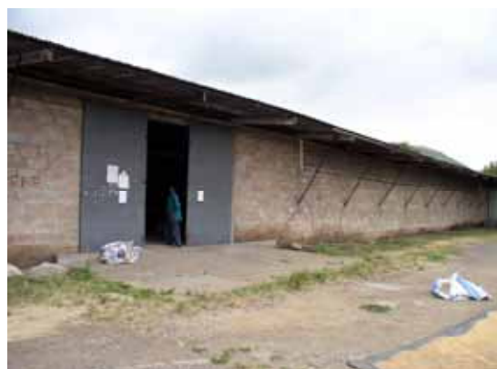
倉庫（貯蔵能力 1,100 トン）
