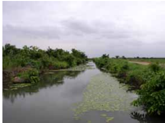
幹線水路（盛土法面）
