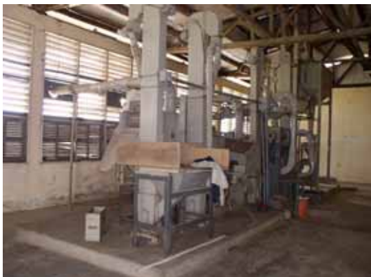
精米施設（サタケ製精米機）
