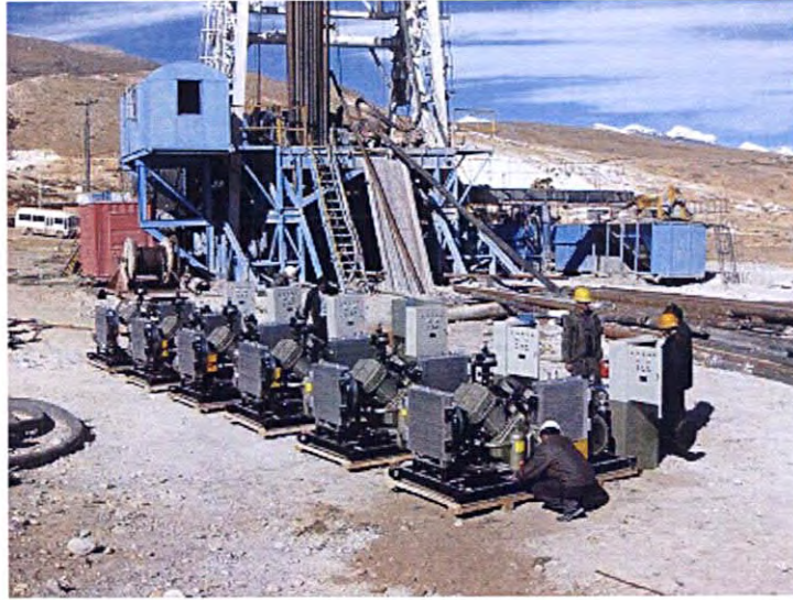
钻机前安装了高压空压机。
