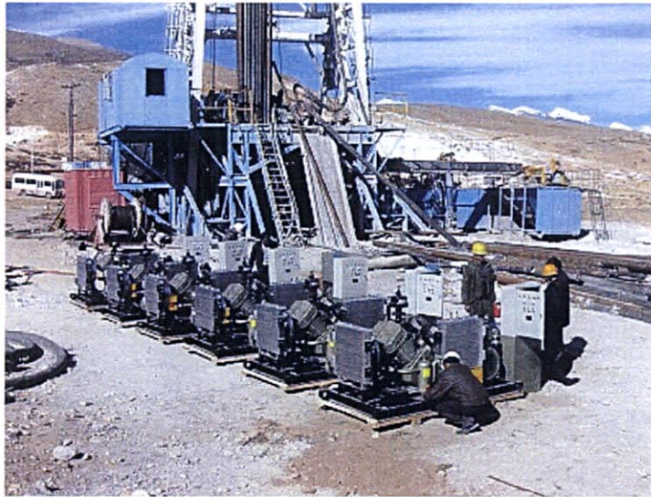
掘削機の前に高圧コンプレッサーを設置した。
