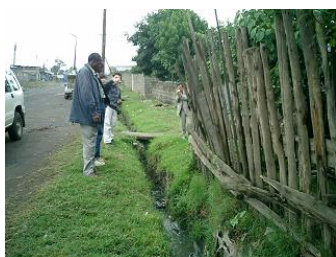
写真－７ 下水が流れ込む排水路
