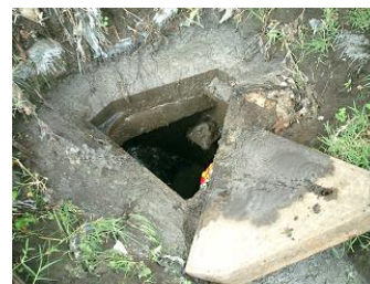
写真－１１ 目詰まり解消
