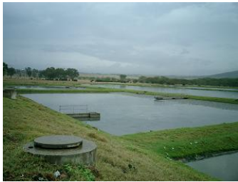
写真-15 通性池～熟成池
