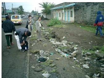
写真－５ 完全に埋まっている排水路
