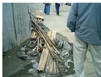
写真-2 ゴミ等により目詰まりを起こした箇所
