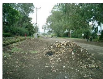
写真-4 雨期の前にしゅんせつされた底泥とゴミ
