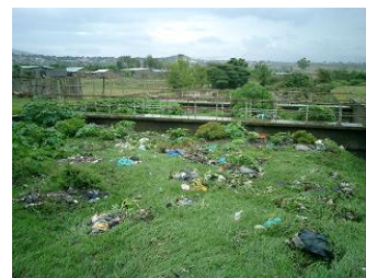
写真-19 雨水滞水池
