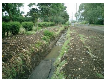
写真-3 市街地住居地域の排水路
