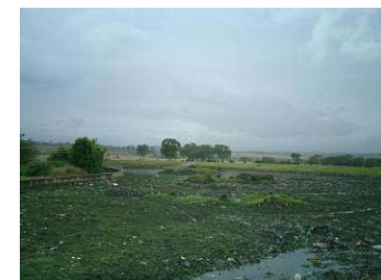
写真-20 雨水滞水池下流部
