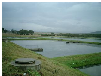
写真6-5 通性池～熟成池
