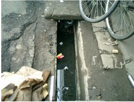
写真6-12 商業地区の排水路
