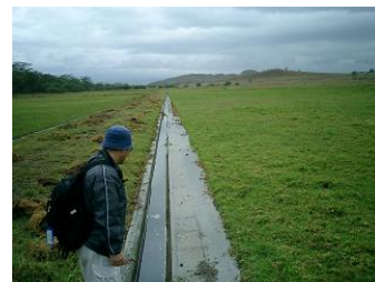
写真6-7 グラスプロット処理
