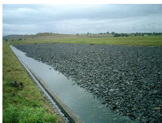
写真6-6 ロックフィルター処理
