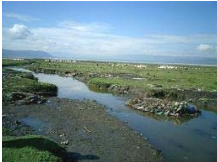
写真6-23 排水路河口部（下流側）
