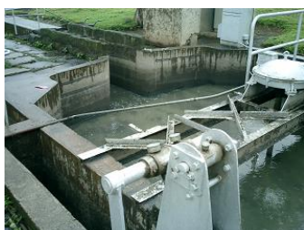
写真6-2 沈砂処理
