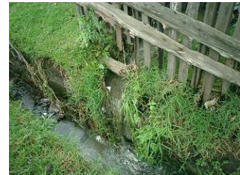
写真6-18 雨水排水路流入部
