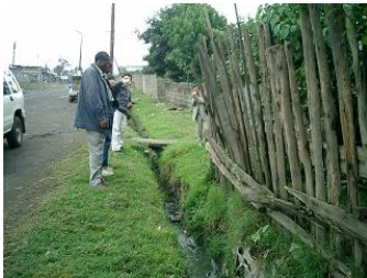
写真6-16 下水が流れ込む排水路
