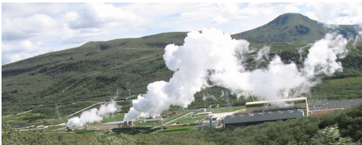
写真 3-4 新設の地熱発電所
