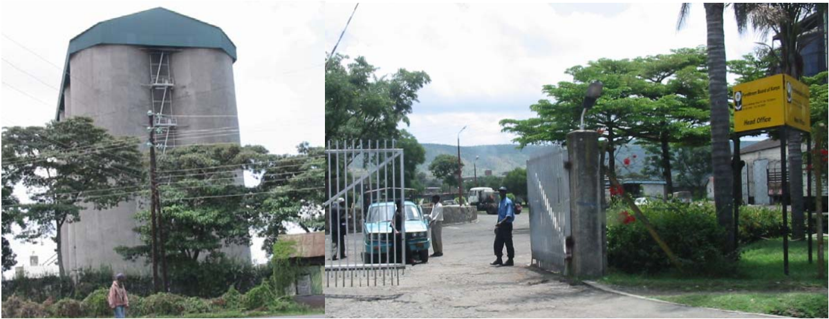
写真 3-5 ナクル市内の穀物倉庫と除虫菊加工工場
