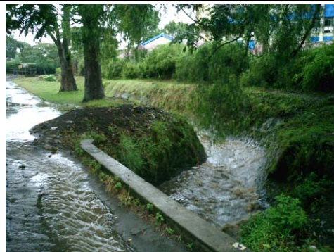
レインストーム直後の雨水排水路の状況 (4/3: ナクル市内)
