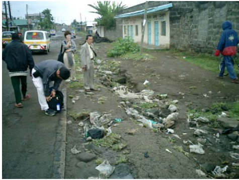
ナクル流域汚染源調査 (4/1: ナクル市内雨水排水路) (土砂・ゴミで埋まっている雨水排水路)
