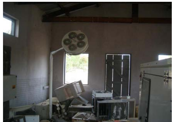
郡病院電圧降下により廃棄された无影灯等(郡病院)
