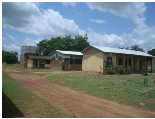
現地工法の病棟・洗濯室等の施設(ジラパ郡病院)
