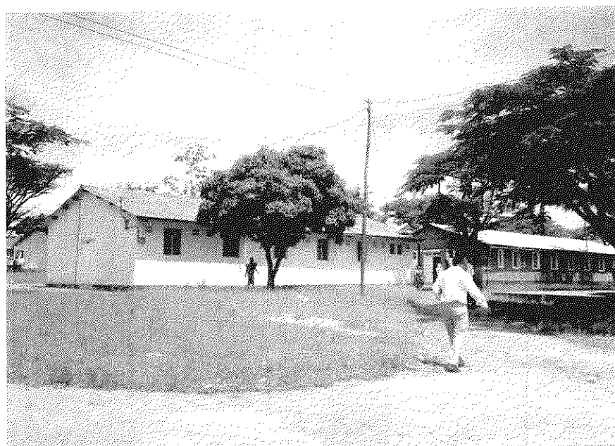
(上) Hombolo 研修施設 (中) 研修生の宿泊施設 (下) 教室棟
