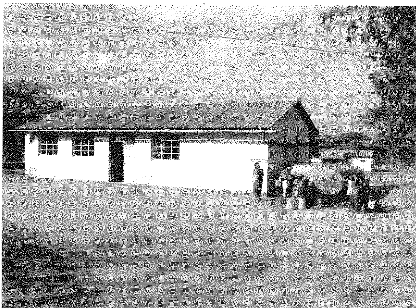
食堂 / 給水施設
