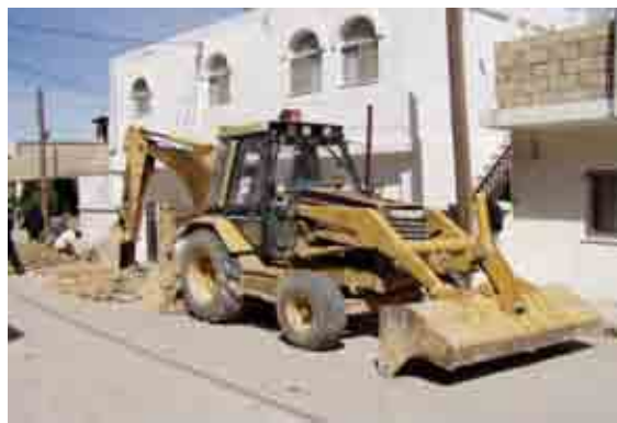
漏水対策工事（Tafieleh GWA） 掘削車両（全国共通仕様）
