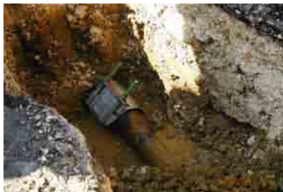
LEMA西部支所 (Amman) 漏水修理 (パッチによる修理完了)
