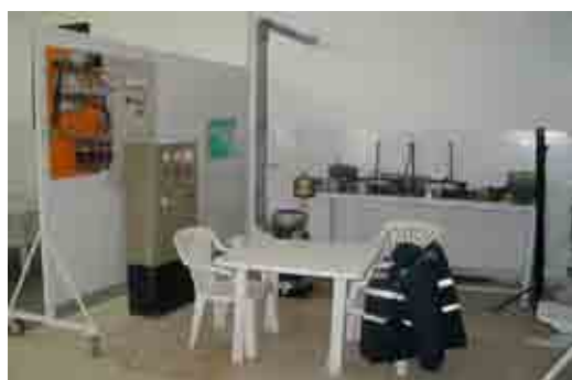
訓練ブース（Marka） ポンプ制御版
