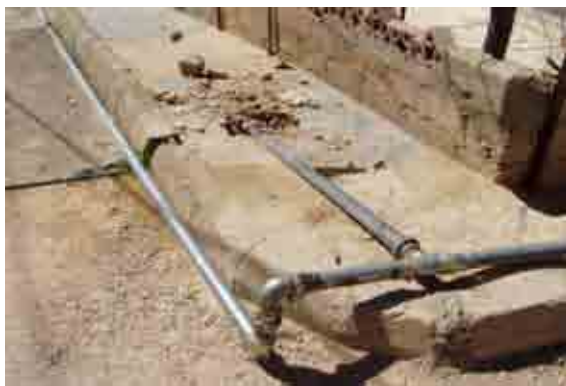
給配水管の更新（Tafieleh GWA） 50A GI（管更新は地上配管）
