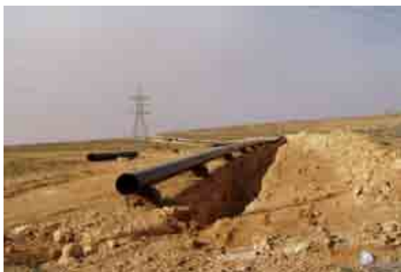
WAJ本庁管轄の導水管新設（Maan GWA） 600A STPG（石灰岩質）
