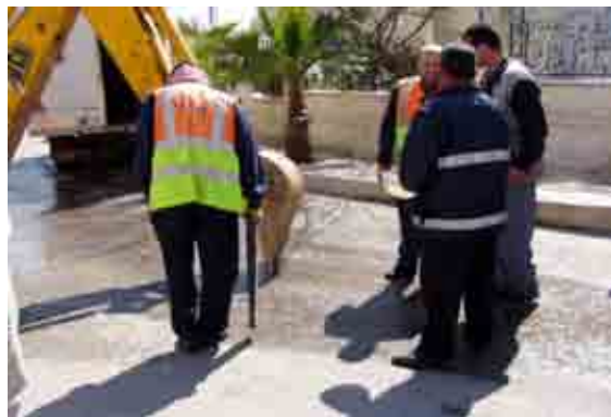
LEMA西部支所 (Amman) 漏水修理 (金属管探知機)
