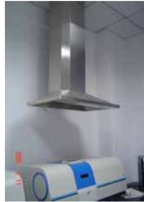
C/P 機関が自ら導入したダクト
