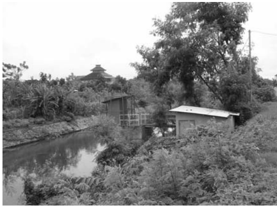
Badung 川河川水位観測所
