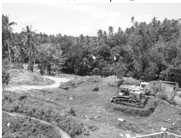
Telaga Tunjung ダムサイト (第一期工事完了)
