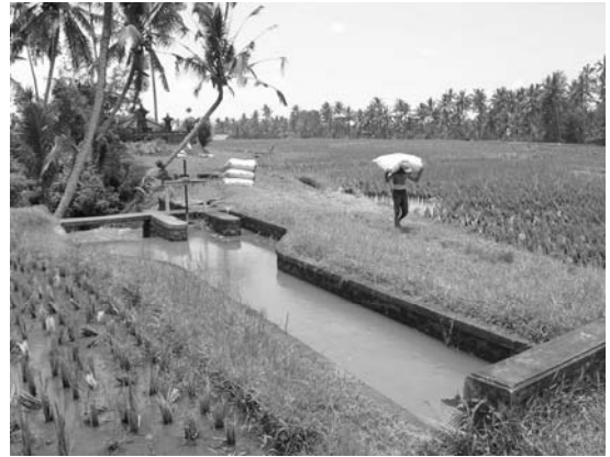
灌漑水路施設
