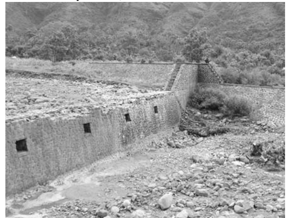
Ayu 川流路工（地下ダム計画案あり）
