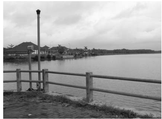
Badung 川河口貯水池
