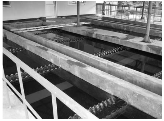
Wariban 浄水場沈殿池
