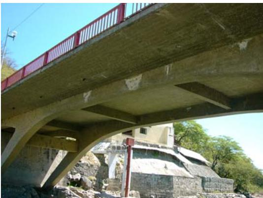
Foto-3 Aparición de sustancias calizas en la junta de construcción entre Losa y la Viga Principal
