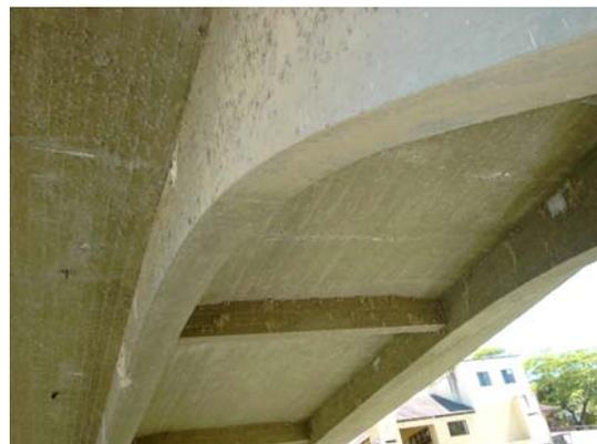
Foto-2 Fisuras en la parte inferior de la Losa
