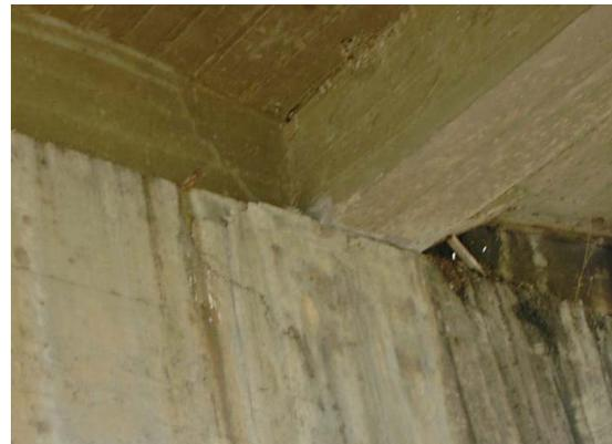
Foto-4 Fisuras en el Estribo, justo por debajo del Apoyo de Hormigón
