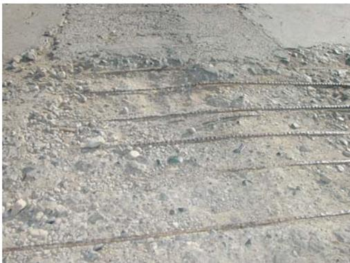
床版の損傷、鉄筋露出
