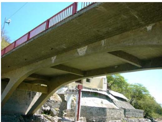
床版と桁の打ち継ぎ部の遊離石灰
