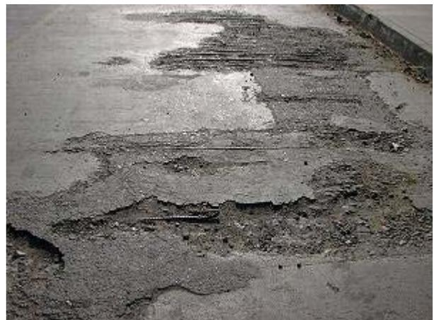
写真-10: 床版表面が磨耗、損傷を受け鉄筋が露出した既設マカラ橋橋面の状況。
