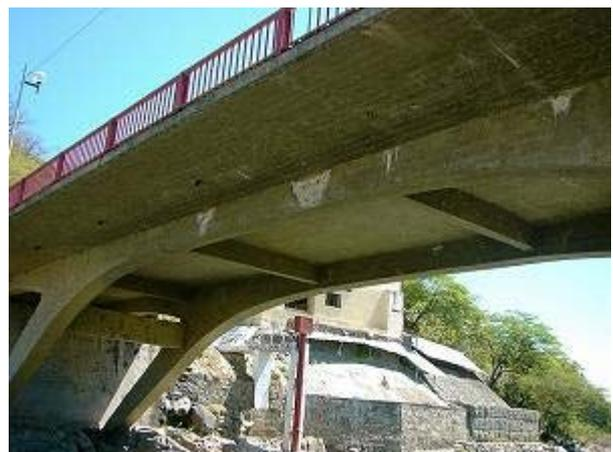
写真-12: 床版と主桁の打継目部に発生した遊離石灰(桁に垂れる白い部分)の状況。
