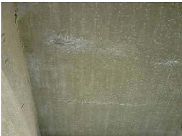
写真-11: 床版裏側の遊離石灰を伴った貫通ひび割れの状況。
