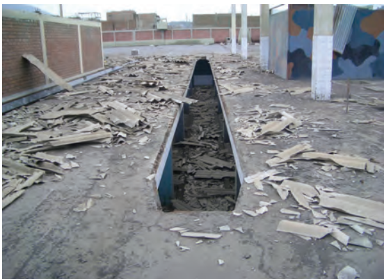
建設予定サイト。一部構造物には地下がある。
