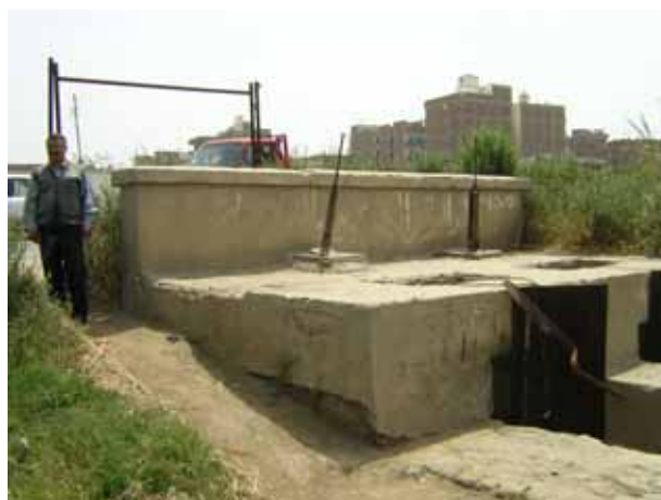
既設の取水施設
