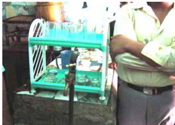
給水状況：一部の地域では、蛇口の給水圧が足らず水がでない状況が慢性化している
