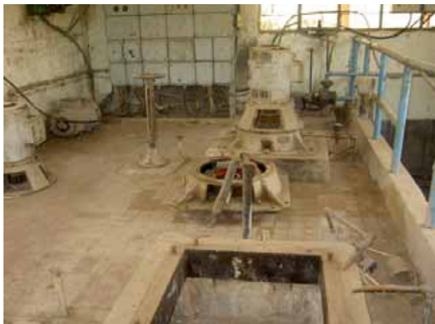
既設汚泥沈殿池ポンプ室内
