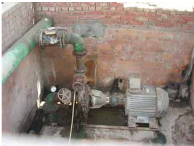
既設井戸設備：多くの井戸水は塩水化が進み、水質は悪化している。特に、塩水化が進んでいるインテイク井戸施設を本計画では廃止する計画とする。
