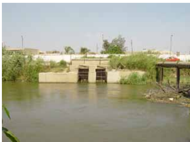
既設取水施設とエルマラ運河
