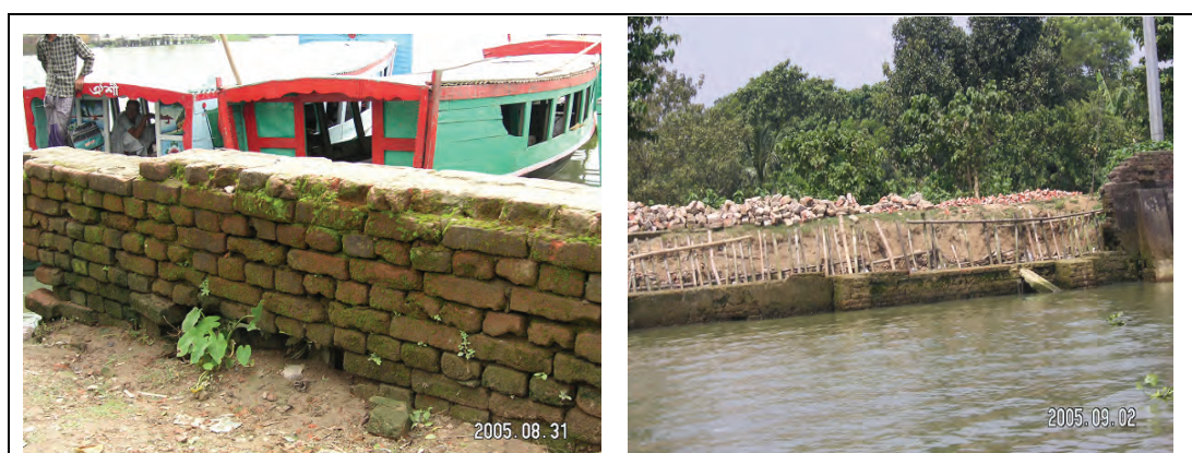
写真2.9 レンガ擁壁（カリアジュリ集落）
