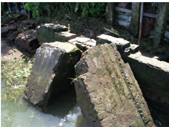
写真-3 崩壊した住民参加型レンガ防波壁 (2005/9/10)
