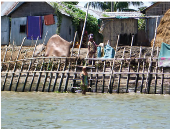
写真-3 崩壊した住民参加型レンガ防波壁 (2005/9/10)
