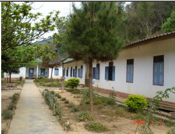
既存施設；入院棟（右）と外来棟（奥）。
