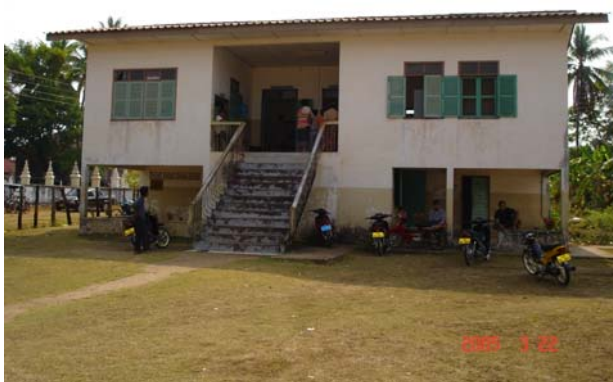
母子保健（地階）と外来（2階）、雨季に洪水あり。
