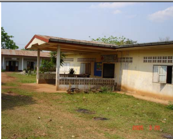
既存施設；外来・検査棟（右）、入院棟（奥）
