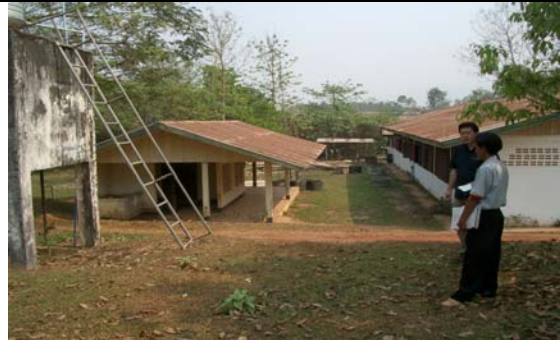
既存施設；本館と便所（左）一段低い位置にある。
