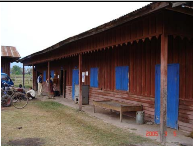
既存入院棟；2005年10月に既に移転した。
