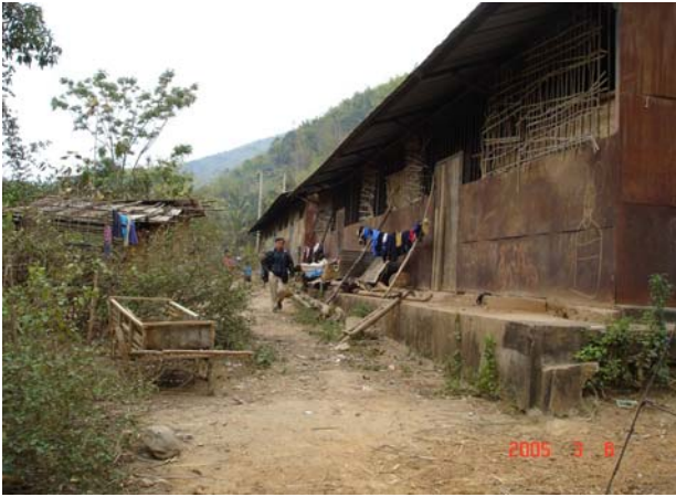
01 移転予定地(古い倉庫を撤去して建設する)
