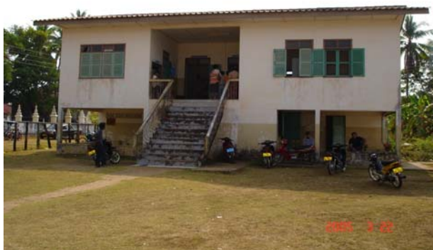
15 既存外来棟(階下の母子保健室は雨季に浸水する)
