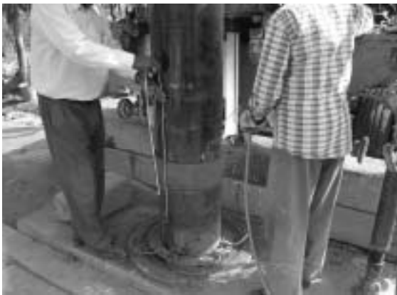
11-UPJNによる掘さく工事
