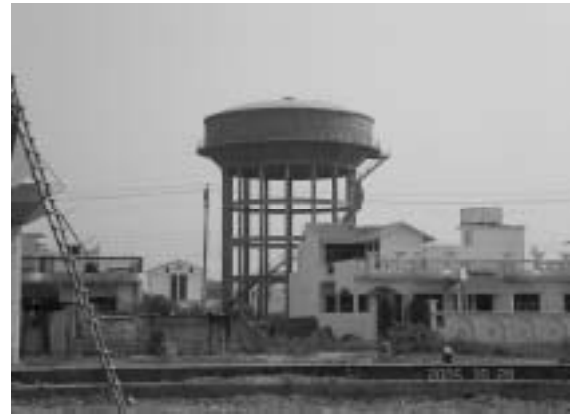
04-既存高架水槽
