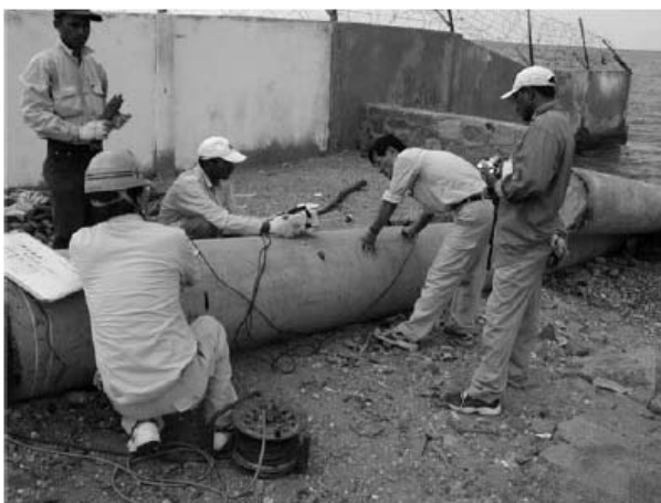
杭の弾性波探査
