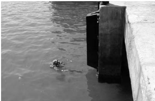
潜水士による杭の外観調査
