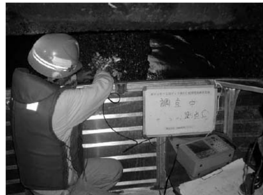
杭の弾性波探査
