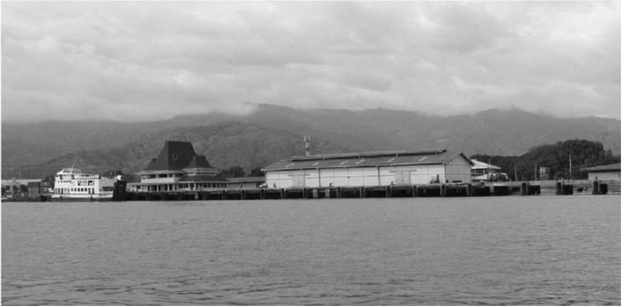
既設棧橋全景（背後の左側建物はパッセンジャーターミナル、右側はBL-9上の上屋）
