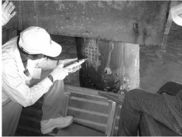
杭の強度測定
