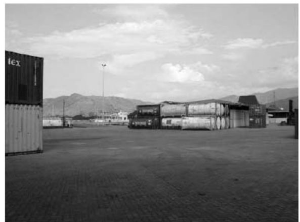
西側コンテナスタッキングヤード BL-5, 6 背後(2003.3 改修)
