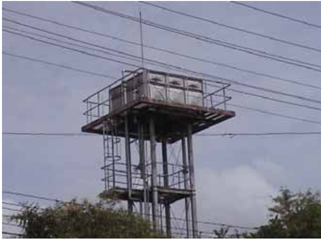
既設タンゴン浄水場 高架水槽
