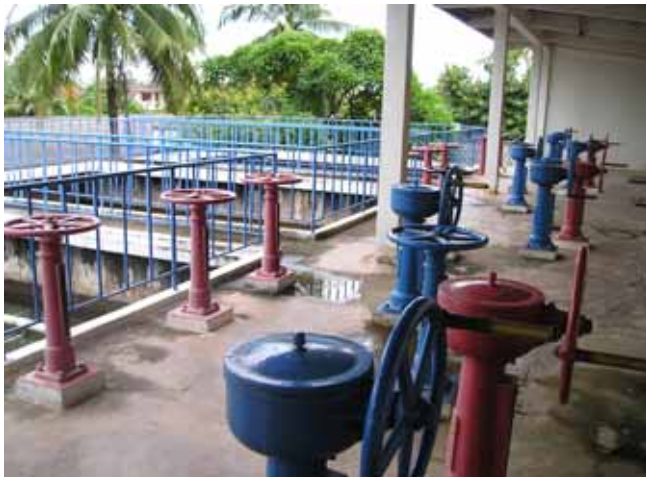
カオリオ浄水場 既設ろ過池上部
