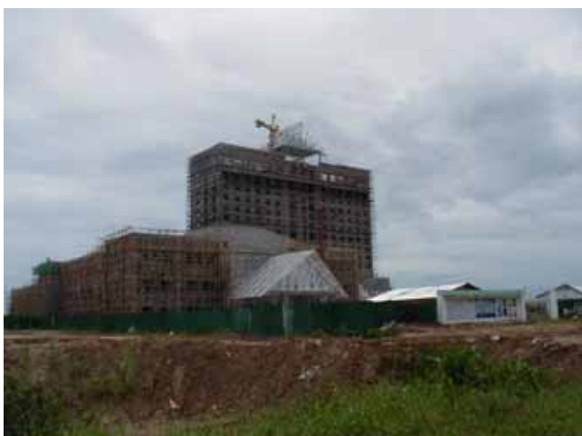
ドンチャン地区におけるホテル建設
