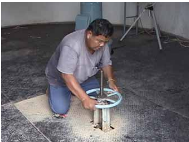
カオリオ浄水場 既設取水塔内仕切弁開閉の様子
