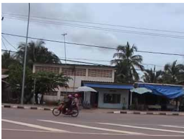
Km6増圧ポンプ場 正面
