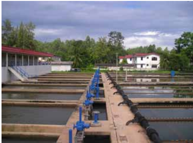
チナイモ浄水場 沈澱池及びろ過池
