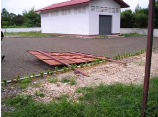
ノンテン高架水槽の倒れた看板
