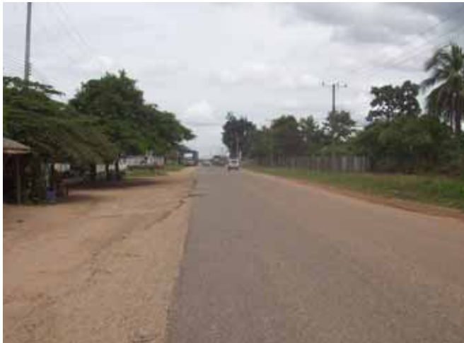
DM4ルート 木材工場付近 配水管 φ 150敷設 (1号線計画と重複する区間)
