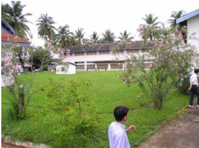
カオリオ浄水場 既設配水池
