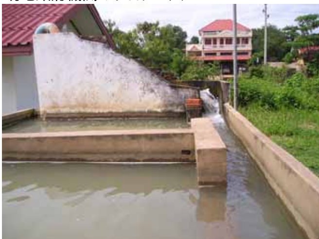
既設タンゴン浄水場 ろ過池
