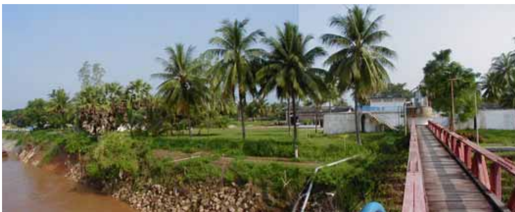
カオリオ浄水場 新規取水施設建設予定地。なお、取水施設の上流から下流にかけて護岸を行う。（写真左下）
