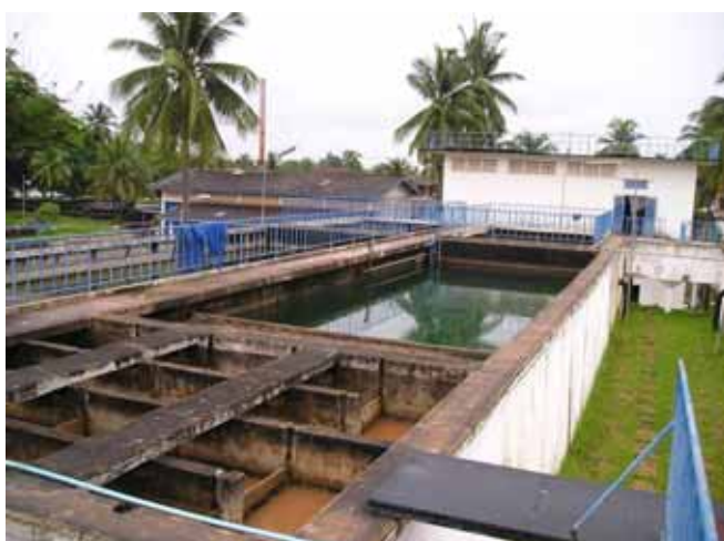
カオリオ浄水場 既設フロック形成池、沈澱池 及び粗ろ過池
