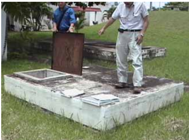
チナイモ浄水場 配水流量計室上部
