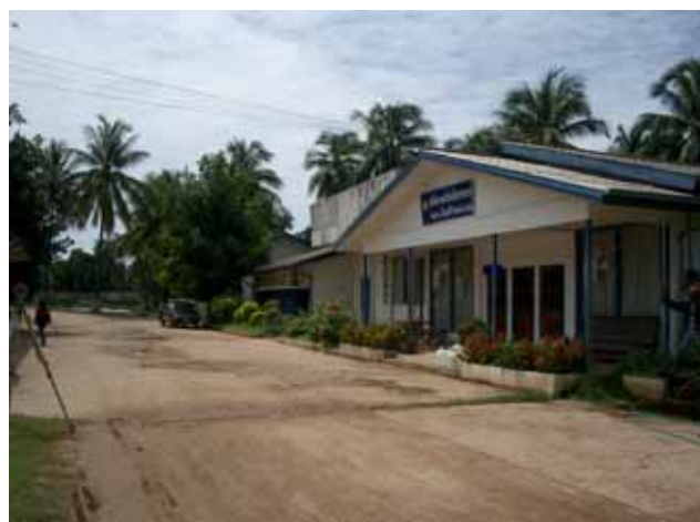
カオリオ浄水場 既設管理棟 (職員事務所、水質試験室を含む)
