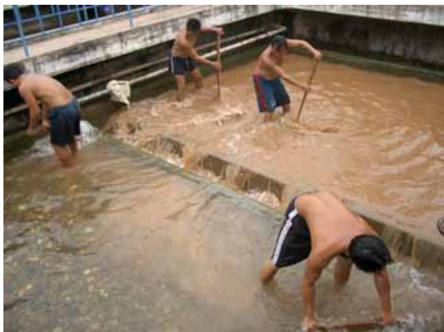
カオリオ浄水場 既設粗ろ過池の排泥の様子
