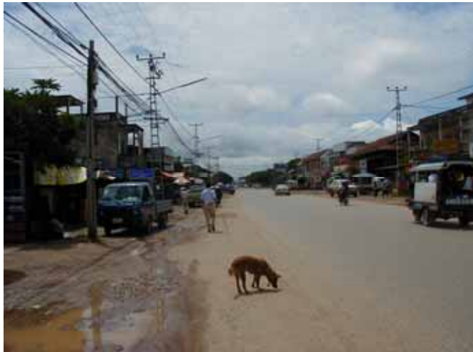
DM1ルート シカイ 交差点付近 配水管 φ600敷設 (我が国無償資金協力「ピエンチャン1号線整備計画」 (以下、「1号線計画」という)と重複する区間)
