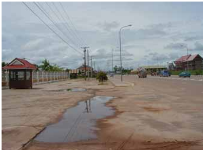
DM2ルート カイソン博物館付近 配水管 φ150敷設
