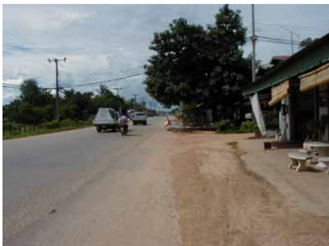
DM3ルート ノンテン増圧ポンプ場付近 配水管 φ150敷設
