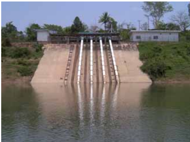
ドンマカイ灌漑用水取水施設
