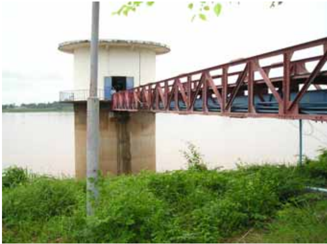
カオリオ浄水場 既設取水塔及び導水管
