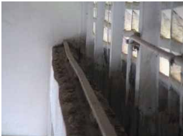
カオリオ浄水場 既設配水ポンプ場天井クレーンの レール (レールが曲がっているため、使用できない)
