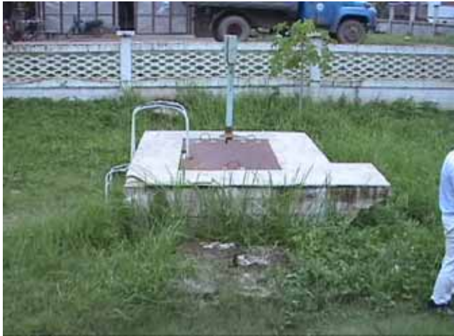
カオリオ浄水場 既設配水流量計室
