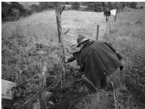
Foto No. 5 Tendido de alambre e instalación de cerca en una finca Proyecto Piloto Cachi.
