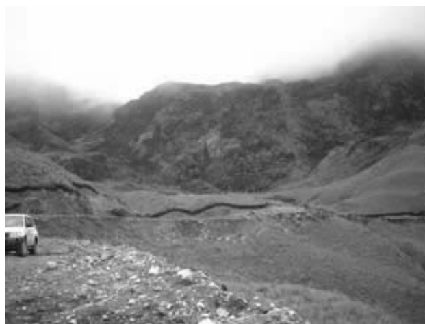
Proyecto conjunto de construcción del canal de riego entre los pobladores y el CREA a través del Programa de Asistencia Financiera No Reembolsable para Proyectos Comunitarios de Seguridad Humana.
