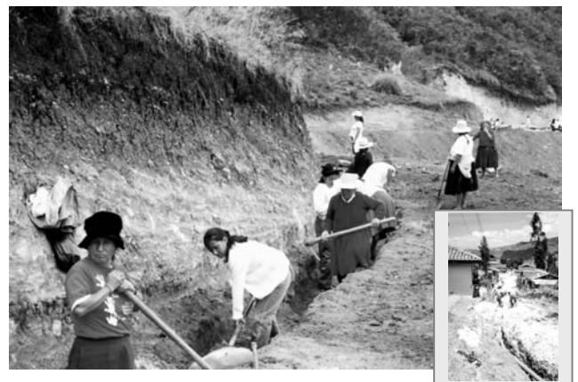
SIGSIG PROYECTO PILOTO Construcción del Canal de Riego por la Minga.
