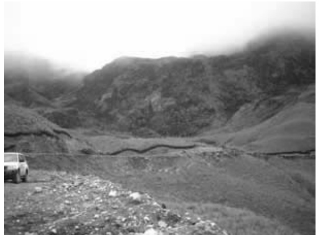
草の根無償 CREA と住民共同による灌漑水路工事
