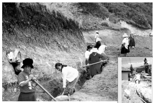
シグシグパイロットプロジェクト ミンガによる灌漑用水路建設
