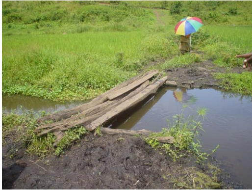
未整備の幹線用水路と橋梁
