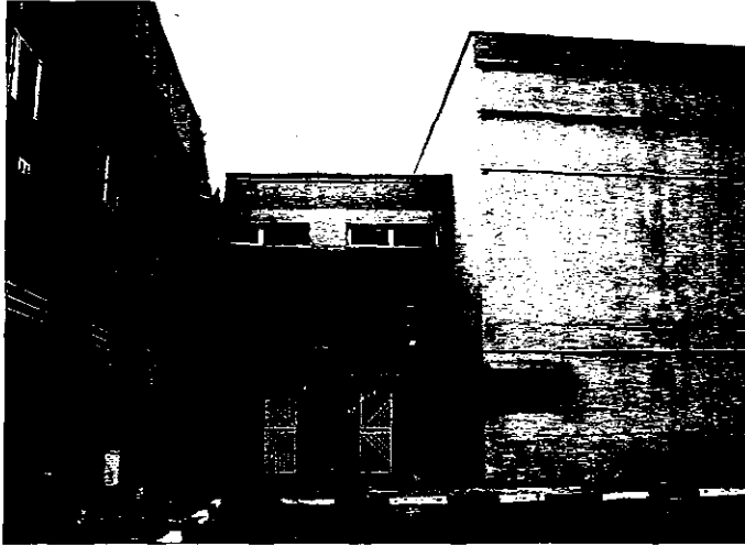
ITC（指導員養成センター） AV 部門棟外観
