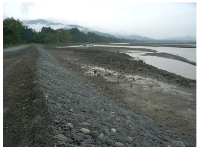
右岸ワウ側上流の AusAID による護岸工事
