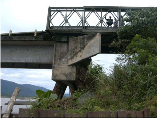
左岸レイ側の橋台補修状況 橋台の裏側が流出したため仮橋(30m)を仮設している
