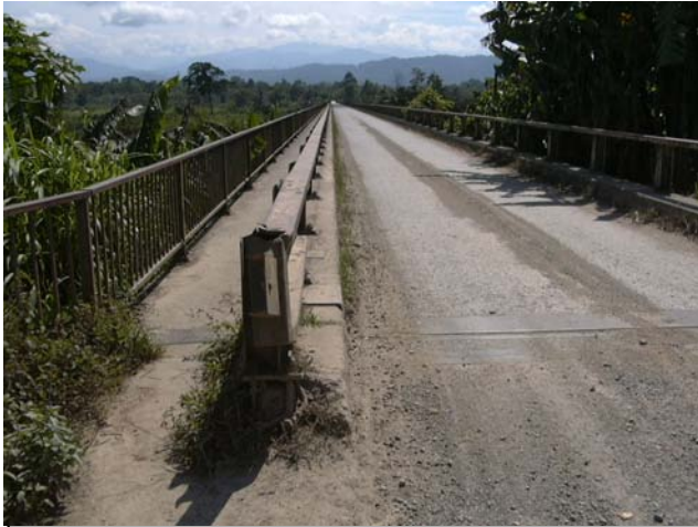
マーカム橋全景 1 (右岸ワウ側から撮影)
