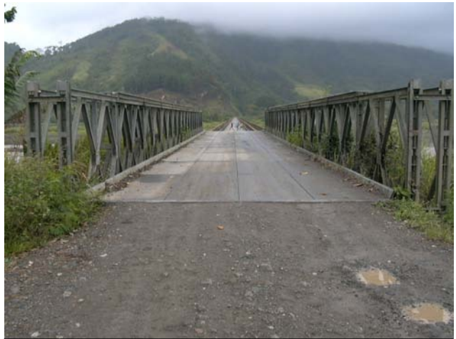
左岸レイ側の仮橋
