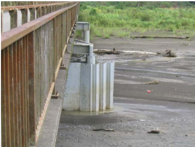
第1橋脚補修状況
