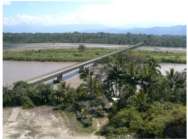
マーカム橋全景 2 (右岸ワウ側から撮影)
