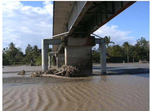
第2橋脚補修状況
