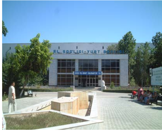
ナボイ州救急医療センター入口
