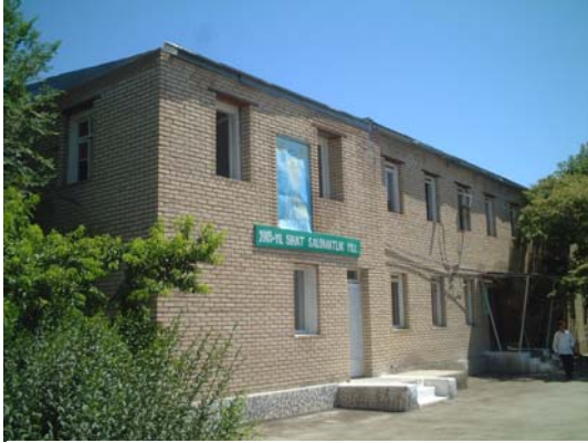
キジルテパ地区病院管理棟外観
