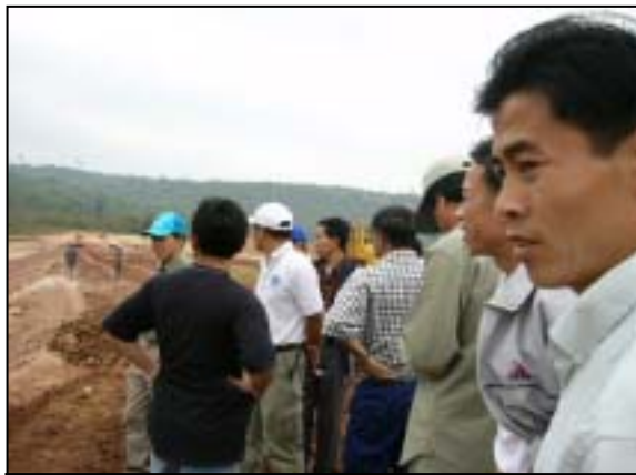
Nam Mang 3 サイト見学 メインダムの建設地(2004年3月5日)
