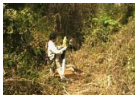
小水力サイトでの測量の様子
