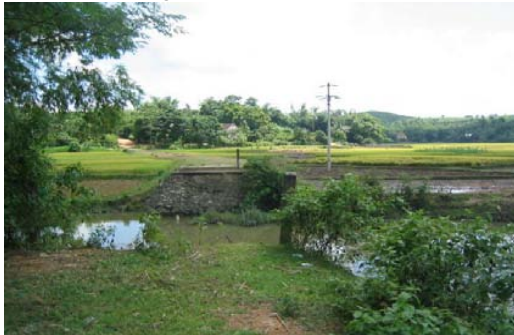
中心地から対岸を望む（橋梁は流失）
