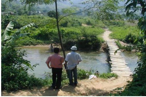
左岸より現橋（木橋）を望む
