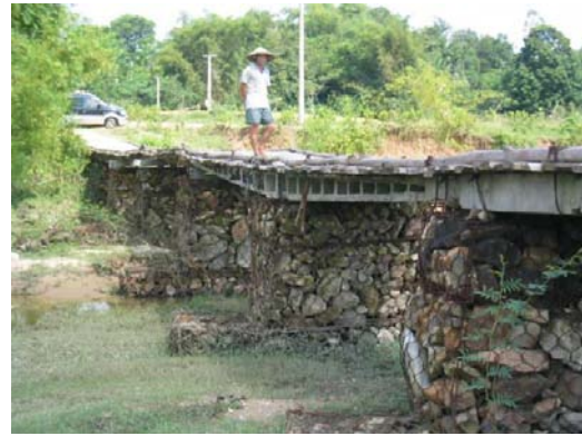
橋脚は蛇籠、梁はコンクリート製電柱を使用
