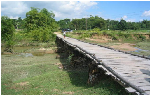
現橋は幅員 2m の木橋
