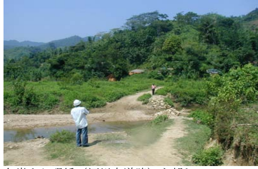
左岸より現橋（河川内道路）を望む
