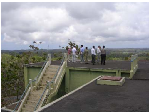
既存配水池 (R5 カラン)
