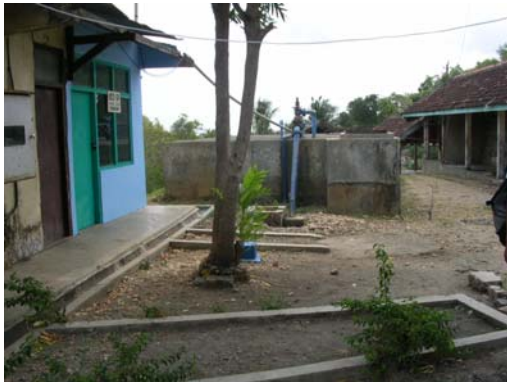
BR4 クマダンバル配水池建設予定地
