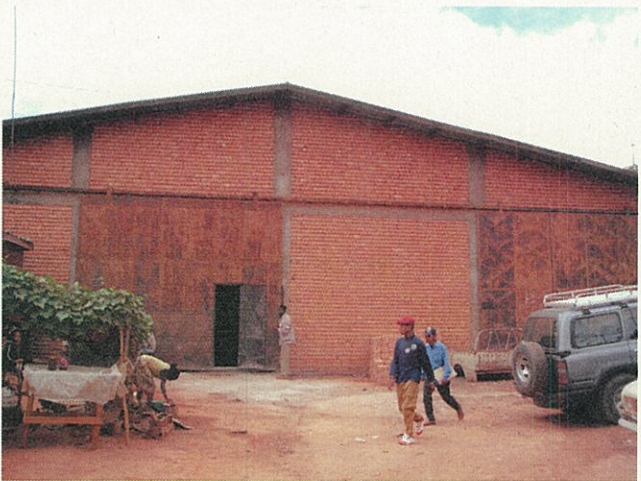
写真11 アンタナナリボの農業牧畜水産省中央倉庫
