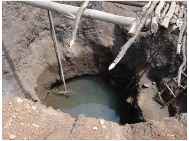
写真2 同じくエクスキャベーターで掘削された浅井戸。毎年補修を必要とする。水位が下がった場合は、さらに掘り下げる。
