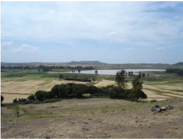
写真3 農業用水のため池。堰堤の維持管理にもエクスキャベーターを含めた建設機械が使用されている。
